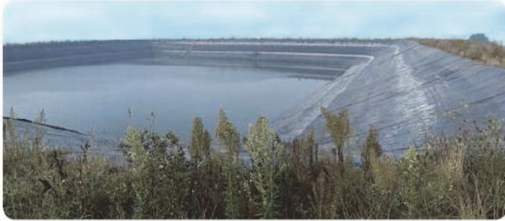
Figure 1. Exemple d'un bassin de substitution étanché par géomembrane
